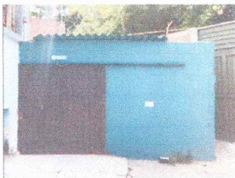
Imagen 8: Cuarto central de almacenamiento de residuos de la ESE Hospital Psiquiátrico San Camilo
