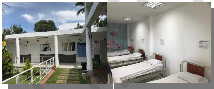
Mantenimiento pintura y resane de unidades clínica mujeres-agudos hombres B.
